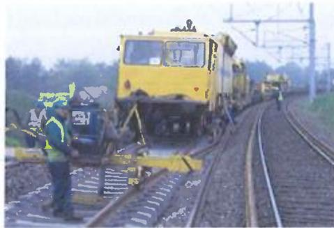
Longs Rails soudés sur traverses béton
