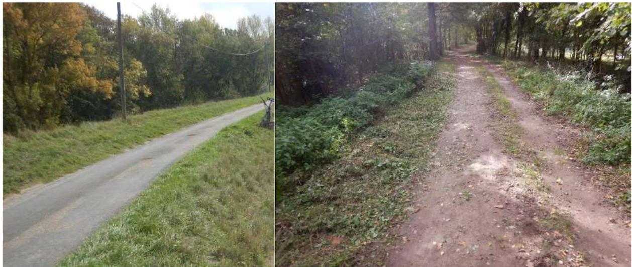
Figure 5-4 : Tronçon 1 de la digue – vue générale (amont avec revêtement et aval sans revêtement)
