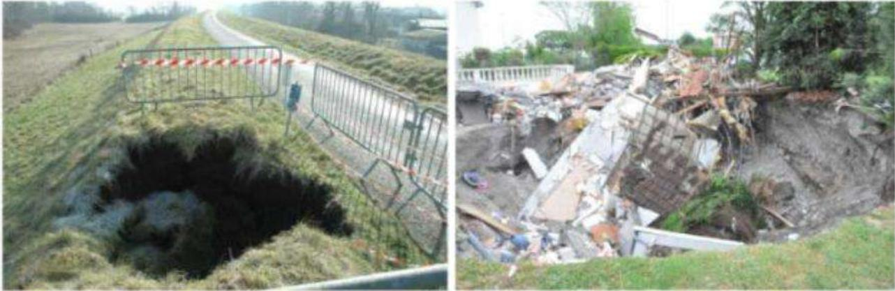
Figure 6-6 : Effondrement karstique sur la digue à Jargeau en 2009 et proche de la digue Saint-Pryvé-Saint-Mesmin en 2010 (source : crédit photo DREAL Centre)
