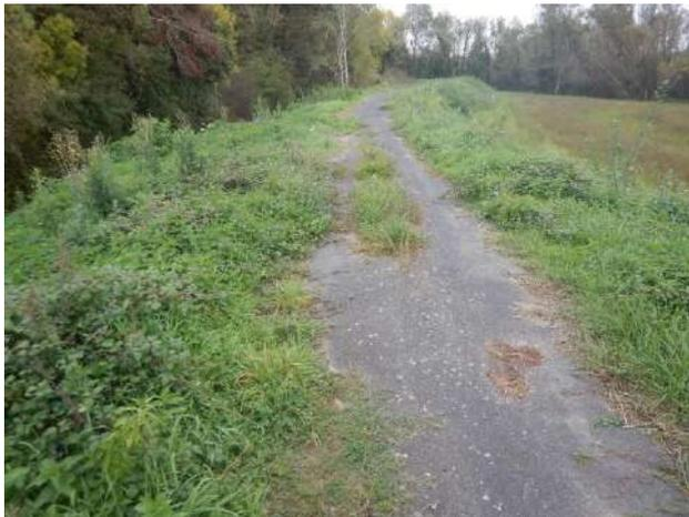
Figure 5-10 : Tronçon 4 de la digue avec revêtement bitumineux en crête – vue générale
