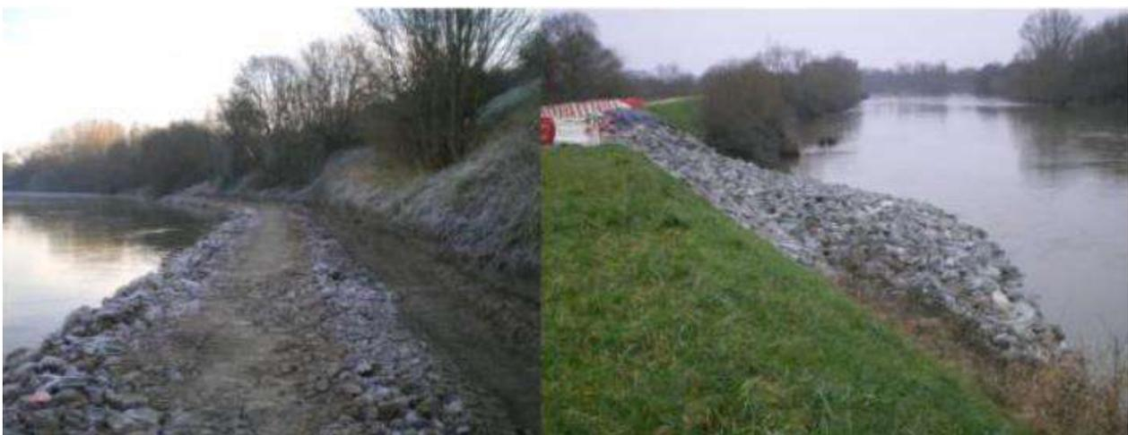
**Figure 6-2 : Piste d'accès dans le lit du Cher, enrochements sur la partie affaissée – Évolution du talus de la levée de Villandry (source : DDT 37)**
