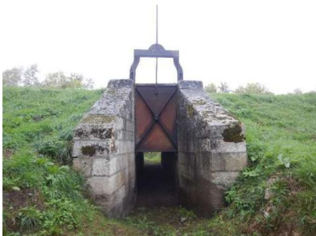
Figure 5-32 : Vannage La Guilmerie – côté rivière
