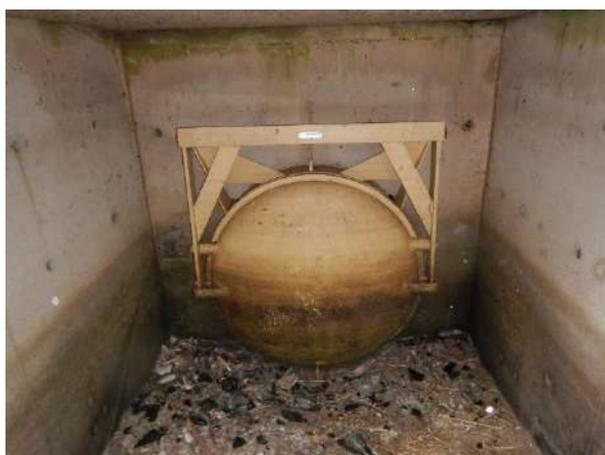
Figure 5-35 : Clapet anti-retour les Boudres
