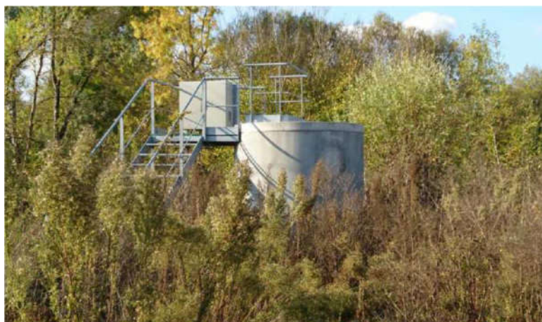
Aménagement de la tête de forage
