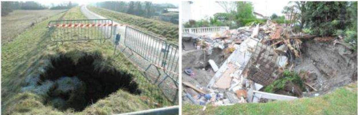
Figure 54 : Effondrement karstique sur la digue à Jargeau en 2009 et proche de la digue Saint-Pryvé-Saint-Mesmin en 2010 (source : crédit photo DREAL Centre)
