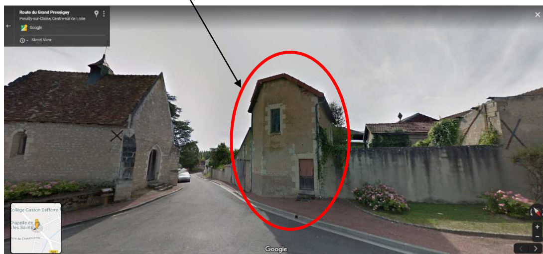
Photographie des bâtiments à détruire – Source : Google Map
