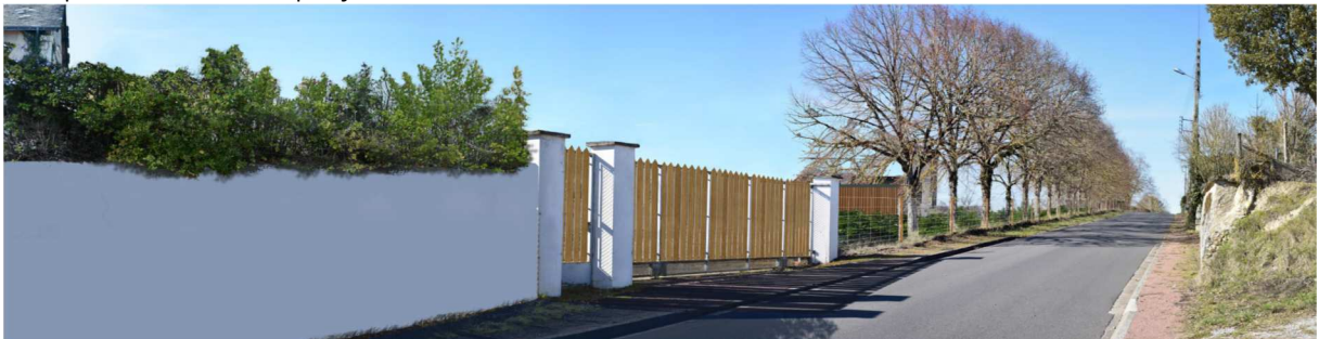
Photographie 37 : Photomontage de l'entrée du parc photovoltaïque des Prés du Maine intégrant la requalification du portail, le mur d'enceinte rallongé jusqu'à la pilasse du portail, le poste de livraison en bardage bois vertical, la clôture type grillage à moutons
