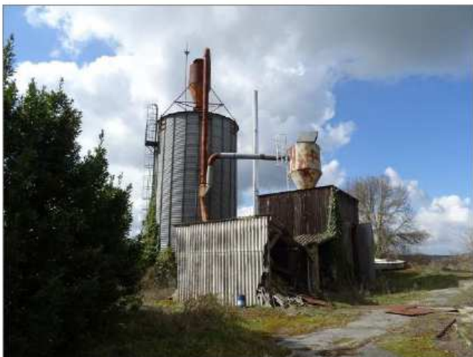
Photographie 4 : Silo à sciure (Source : ENCIS Environnement)
