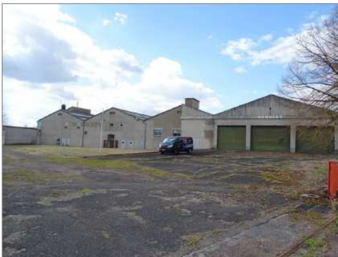
Photographie 2 : Hangars industriels (Source : ENCIS Environnement)
