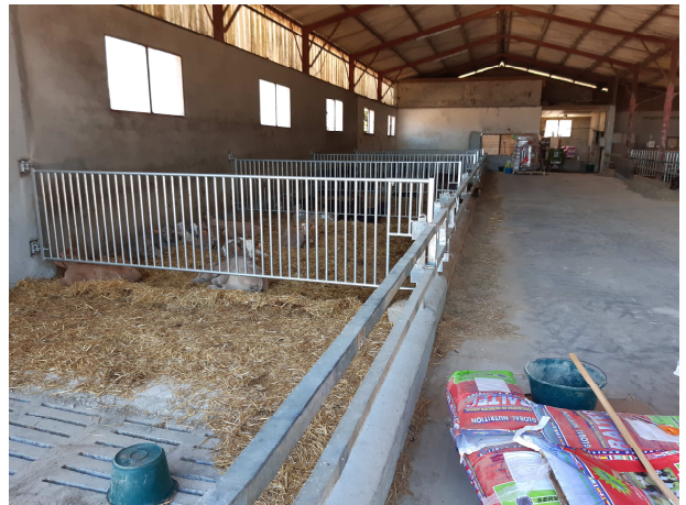
Vue du bâtiment n°7 – depuis le pignon Sud-Est
