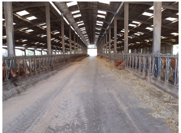
Vue du bâtiment n°5 – couloir de distribution central
