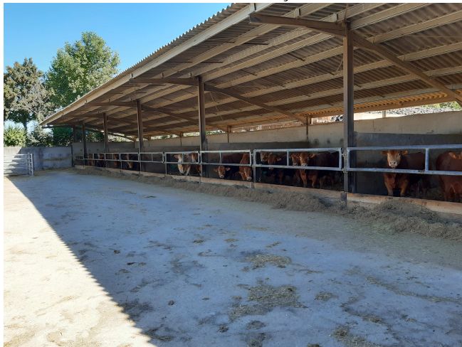
Vue du bâtiment n°4 – façade Sud-Ouest
