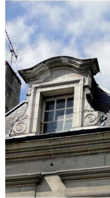
Le mauvais état des toits et de la zinguerie entraîne des fuites des eaux pluviales sur les façades
