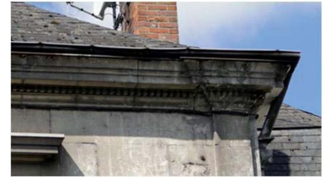
Désordres dans l'appareil en pierre de taille des étages (dislocation des joints au niveau des linteaux et corniches, dévers par défaut de chaînage).
