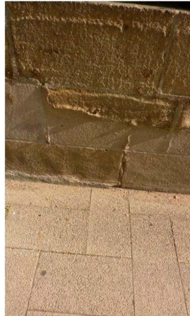
Eviter les revêtements de sol étanches ne laissant pas passer l'humidité, qui se trouve renvoyée dans la maçonnerie des édifices par remontée capillaire
