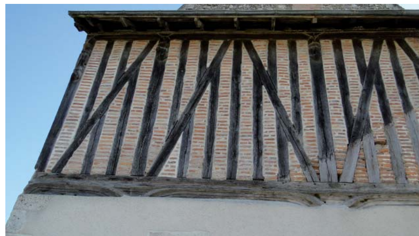
Pan de bois remplissage en brique
