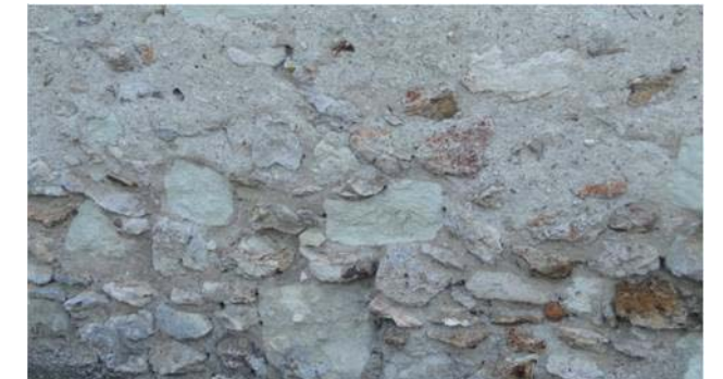
Appareil de moellons (Calcaire lacustre de Touraine)
