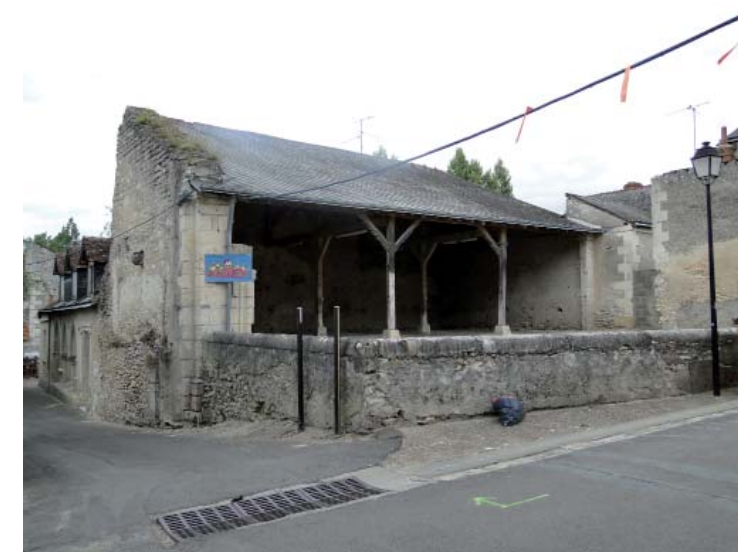
Etat actuel du croisillon nord de l'église abbatiale (Halle aux Moutons)
