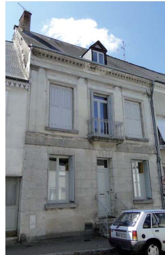
Façade néoclassique masquant une maison du 15e siècle
