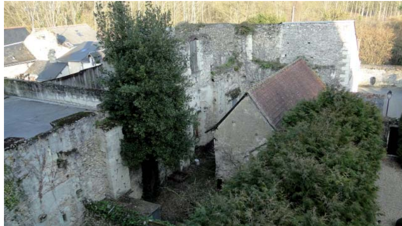
L'aile orientale mauriste et les vestiges de l'ancien dortoir
