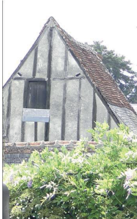
Pan de bois remplissage en torchis
