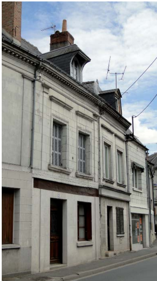
Façades néoclassiques unifiées
