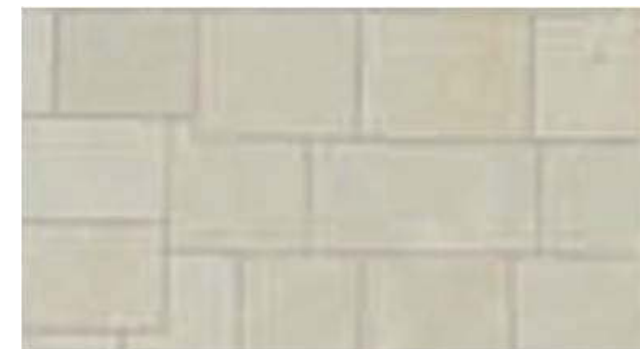
Appareil de pierre de taille (tuffeau)
