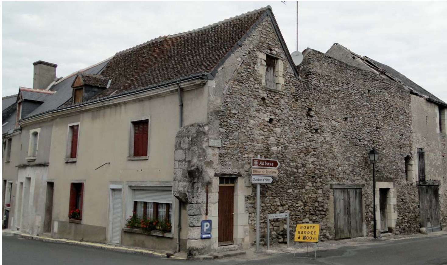
Le bâti ancien, masqué Bâti adossé à l'enceinte
