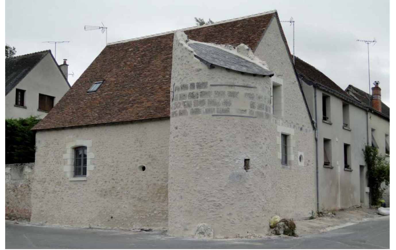
Le bâti d'époque médiévale : Vestige d'un élément de fortification du bourg
