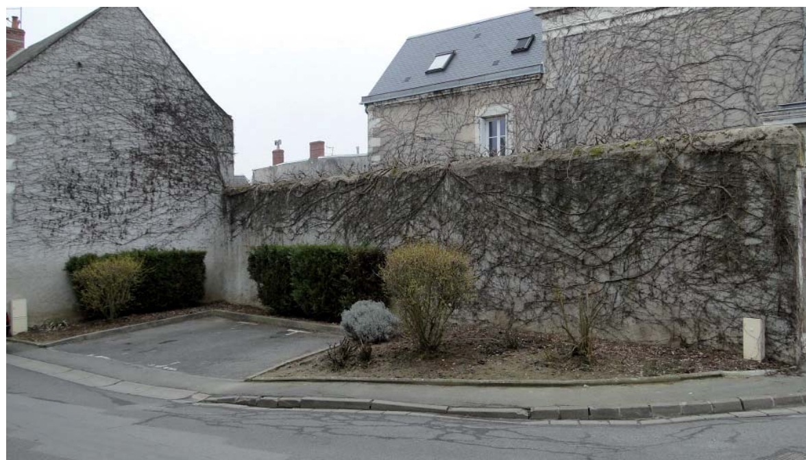
Des démolitions qui ne peuvent être accompagnées d'une cicatrisation du tissu urbain créent des brèches dommageables dans le paysage
