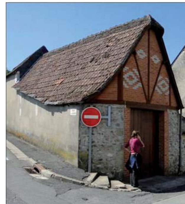
La brique comme matériau de remplissage des maisons à pans de bois
